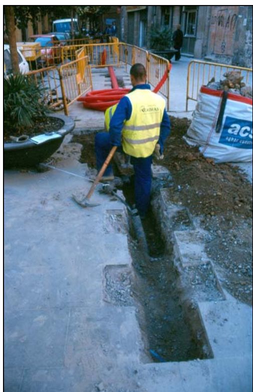
FOTO 3: Instal·lació de serveis a la rasa 2.
