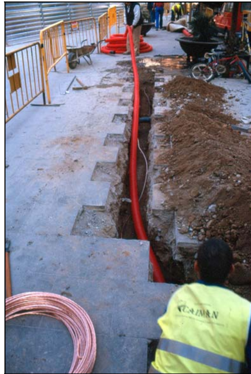
FOTO 6: Instal·lació de serveis a la rasa 2.
