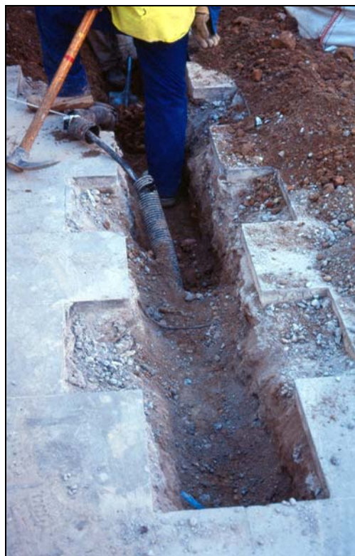
FOTO 4: Instal·lació de serveis a la rasa 2.
