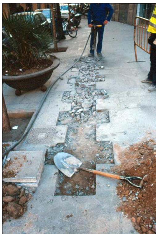
FOTO 1: Obertura de la rasa 1.
