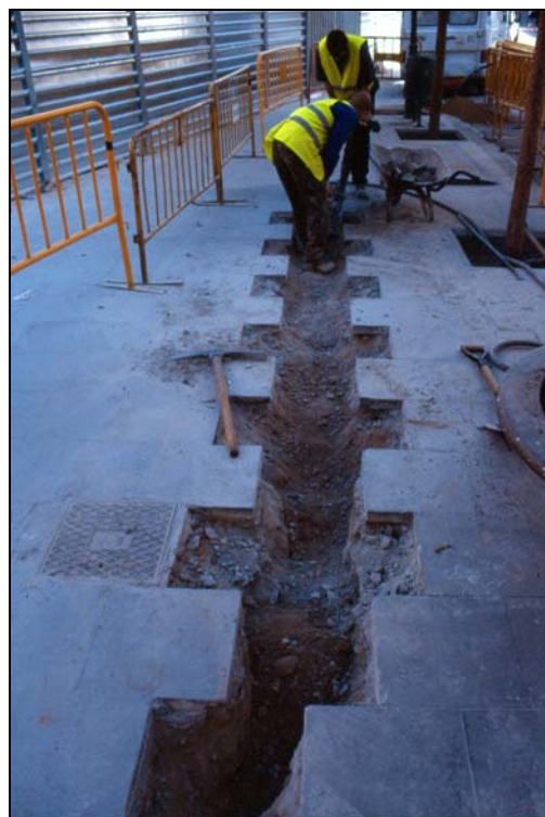
FOTO 2: Excavació de la rasa 2.
