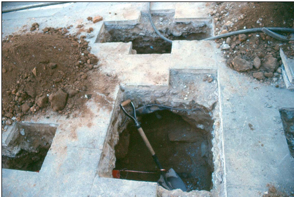
FOTO 7: Excavació de la cala 1 per a la instal·lació de serveis.
